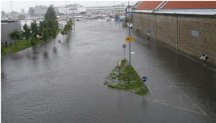
Bild 3 - Die Hafensperrmauer wird immer wieder überschwemmt. Quelle: epasit
