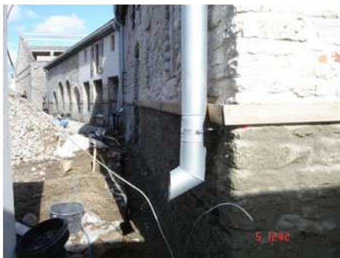
Bild 8 – Der Gebäudesockel wird abgedichtet. Quelle: epasit
