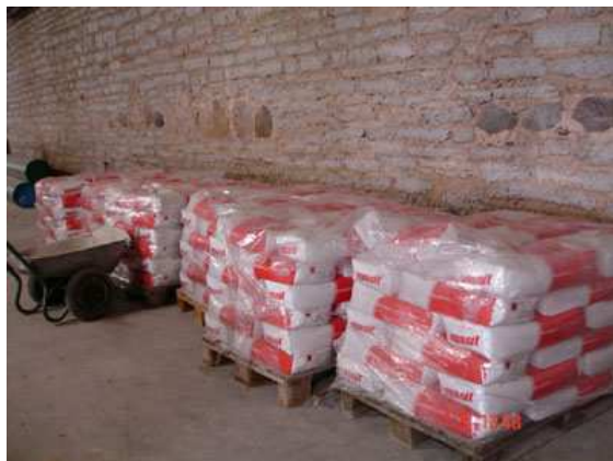
Bild 6 - Palettenweise MineralDicht Sperrputz wurde auf der Baustelle verarbeitet. Quelle: epasit
