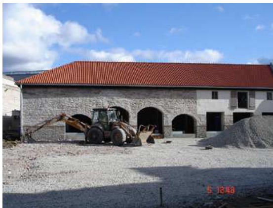
Bild 7 - Während der Sanierungsarbeiten. Quelle: epasit
